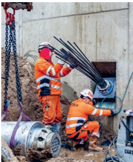
↑ Installazione della scatola dinamometrica per gli ancoraggi multibond sull'area della nuova stazione di Groningen
