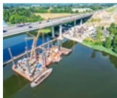
↑ Nuova costruzione Rader Hochbrücke / Pagina 14
