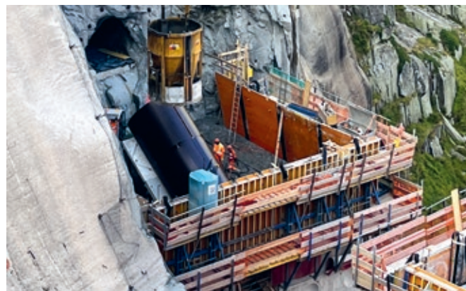
↑ Circa 500 m 3 di calcestruzzo vengono impiegati ogni giorno. In questo modo i blocchi crescono di tre metri in altezza.
