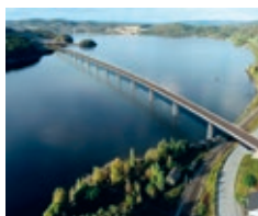
↑ Bau Tangenvika-Brücke / Seite 19
