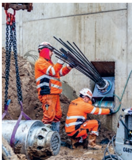
↑ Einbau der Kraftmessdose für die Multibond-Anker auf dem Gelände des neuen Bahnhofs Groningen
