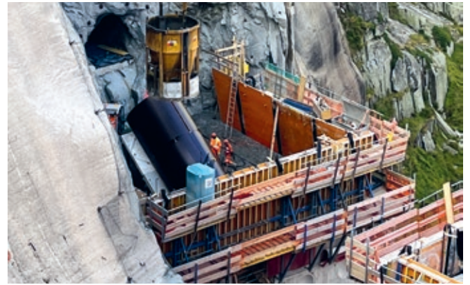
↑ Rund 500 m 3 Beton werden täglich verbaut. Damit wächst einer der Blöcke 3 m in die Höhe
