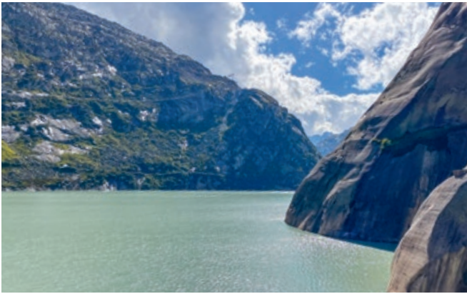
↑ Der Grimsel-Stausee ist mit fast 100 Mio. m 3 Wasser zentral für die Energieversorgung der Schweiz
