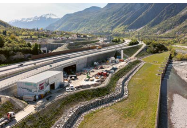
↑ Panoramica del cantiere TELT C008
