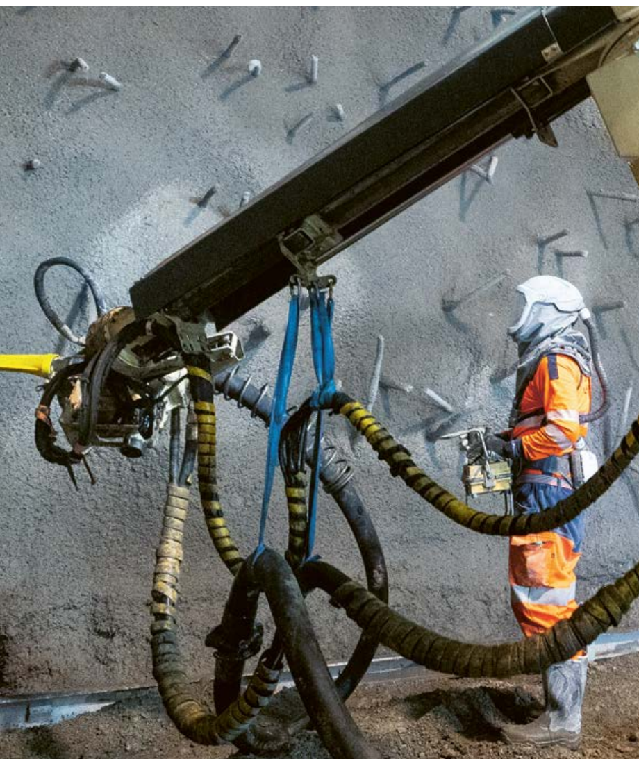
↑ Proiezione di calcestruzzo dopo la posa di una centina
