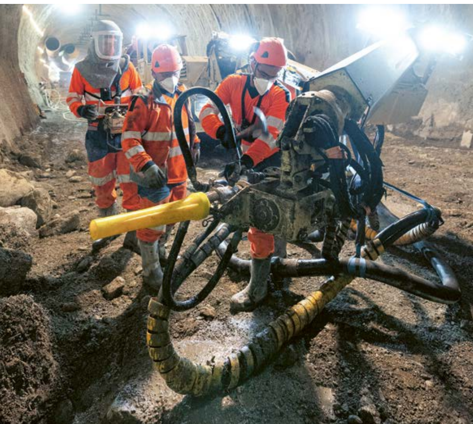
↑ Manutenzione del robot che proietta il calcestruzzo proveniente dalle miscelatrici
