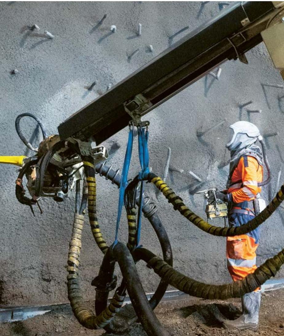
↑ Projection de béton après la mise en place d'un cintre
