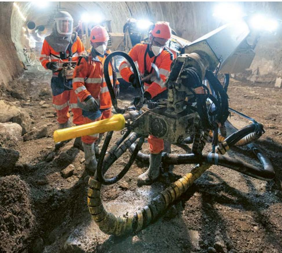
↑ Maintenance du robot à projeter le béton
