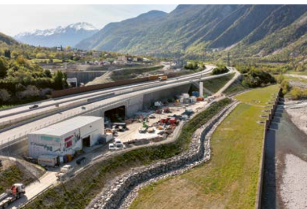
↑ Übersicht über die TELT-Baustelle C008
