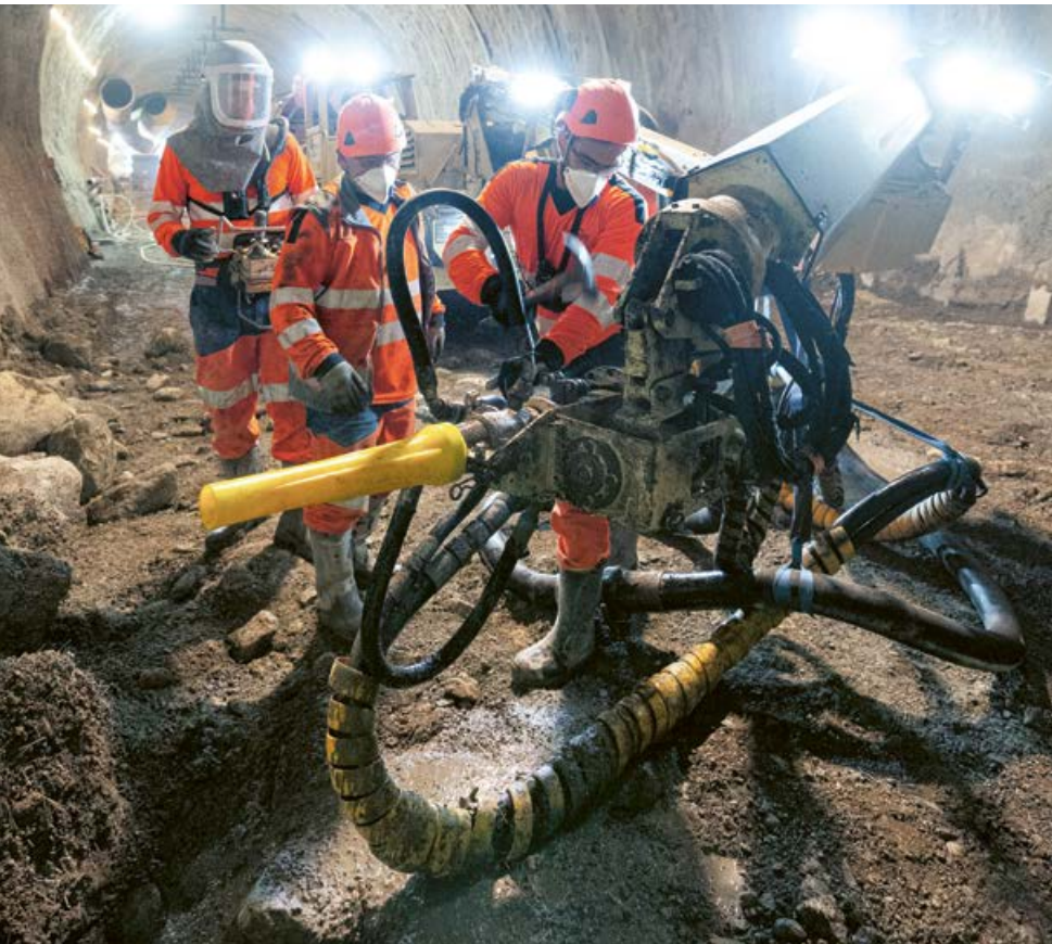
↑ Wartung des Beton-Spritzroboters, der den von Betonmischern zugeführten Beton aufträgt
