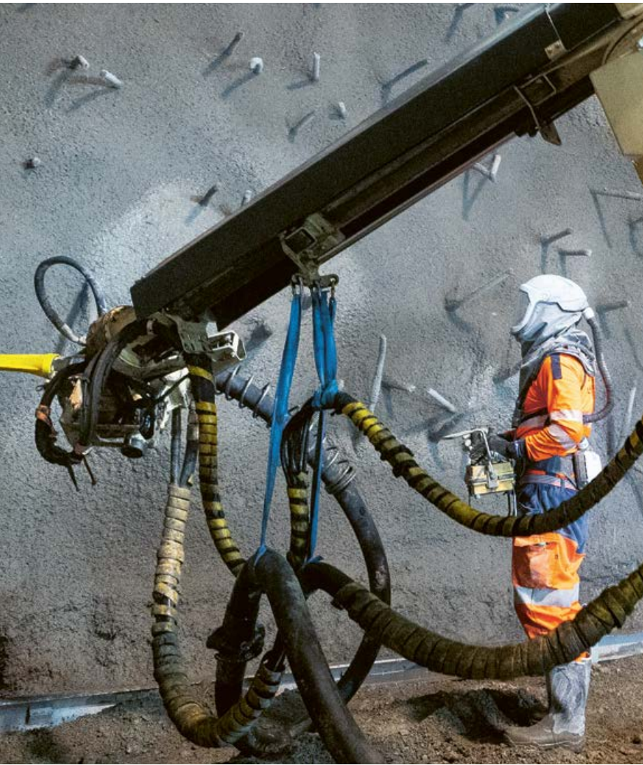
↑ Betonspritzen nach dem Einbau eines Bogens
