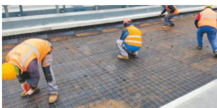
Rumänien – Baustelle Lot 4 CFR Um uns gegenseitig zu schützen: Abstand halten auch beim Arbeiten.
