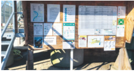
Deutschland – Baustelle Mülheimer Brücke, Köln Infoplakate: An den «schwarzen Brettern» hängen die Infoplakate mit den Massnahmen zum Schutz gegen COVID-19.
