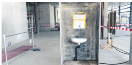
Schweiz – Baustelle Evolution+/Quartier de l'Étang, Îlot E, Vernier Abstand halten und Hygiene: Markierungen helfen, um in den Warteschlangen vor den Händewaschstationen den Abstand zu wahren.
